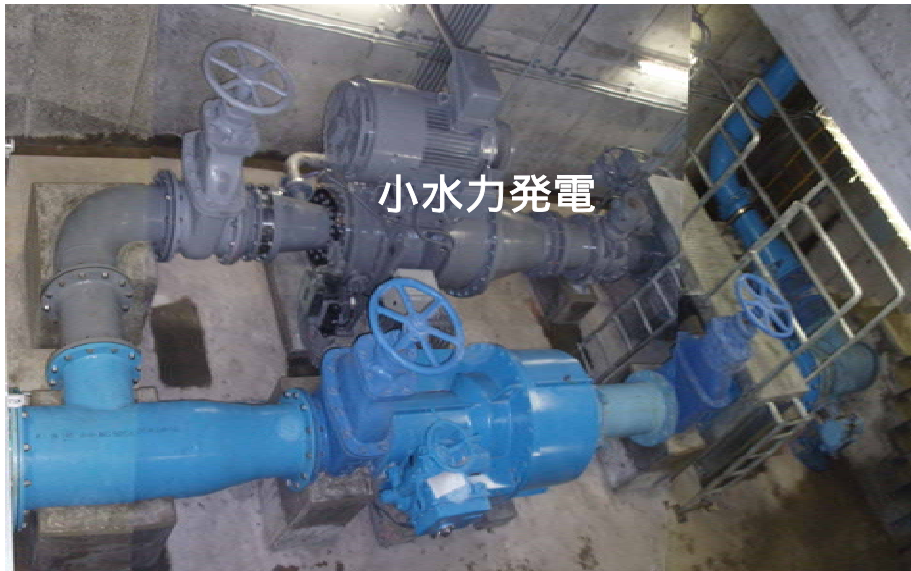
図 2 - 13 「小水力発電施設」
